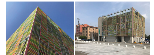
Casa della Salute G. P. Vecchi, Modena, 2020 ZPZ PARTNERS
